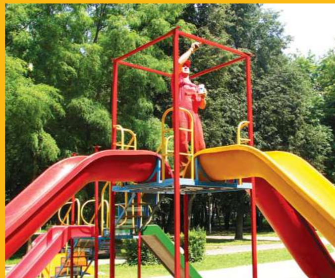
Косметический ремонт игрового комплекса в Центральном детском парке имени М. Горького провели сотрудники предприятия
