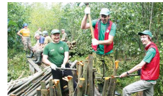
Плотину на Ельнянке укрепляли по «полесскому» методу, который не использовался здесь ранее
